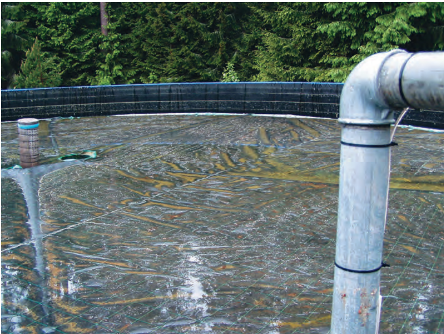
Ryc. 39. Zbiornik z systemem przykrycia lustra wody
