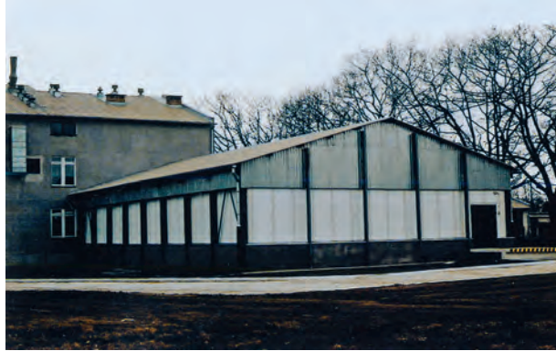
Ryc. 116. Przechowalnia nasion i stratyfikatorium przy Stacji Nasiennictwa Leśnego w Nadleśnictwie Białogard (RDLP Szczecinek)
