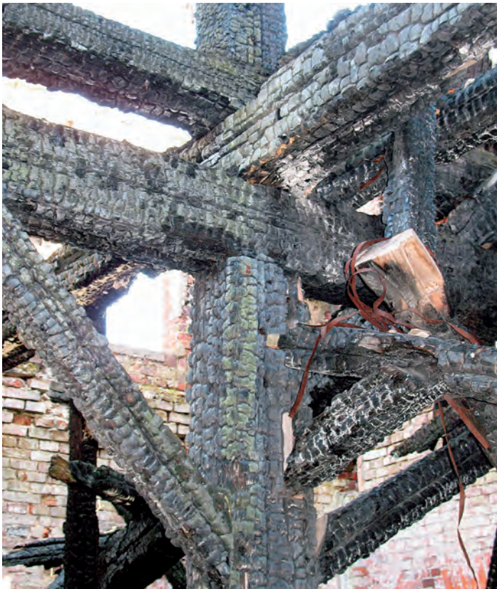
Fot. 3. Spalona konstrukcja drewniana zabytkowego spichlerza w Giżycku (fot. P. Kozarski)
