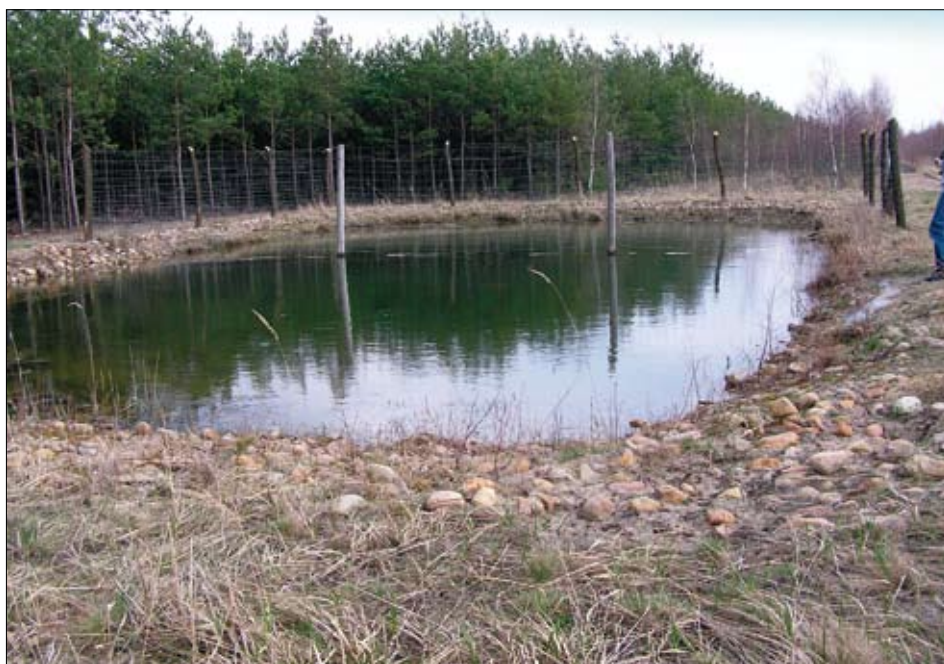
Zbiornik wody do celów gaśniczych z dostępnym brzegiem dla zwierzyny
