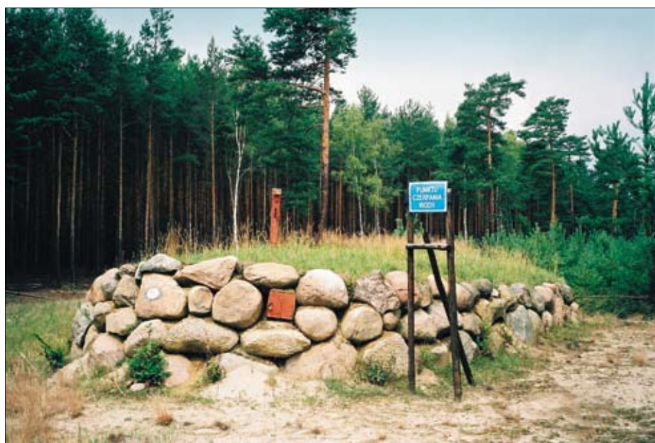
Sztuczny zbiornik wody (zakryty) o pojemności 50 m 3
