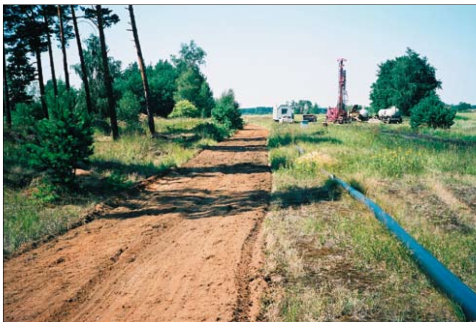
Pas izolacyjny zabezpieczający przed przerzutem ognia od prowadzonych w sąsiedztwie lasu prac pożarowo niebezpiecznych
