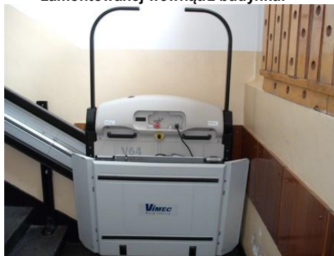
Fot. 4. Przykład platformy poręczowej zamontowanej wewnątrz budynku.
