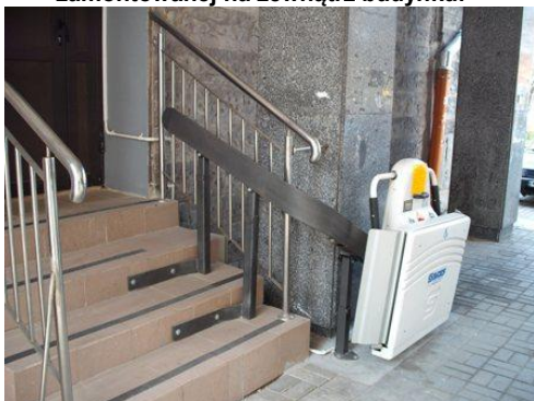
Fot. 3. Przykład platformy poręczowej zamontowanej na zewnątrz budynku.
