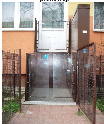
Fot. 2. Przykład zewnętrznej platformy pionowej.
