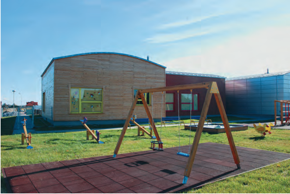
Fot. 20. Przedszkole w miejscowości Szczerców (fot. Andrzej Noskowiak)
