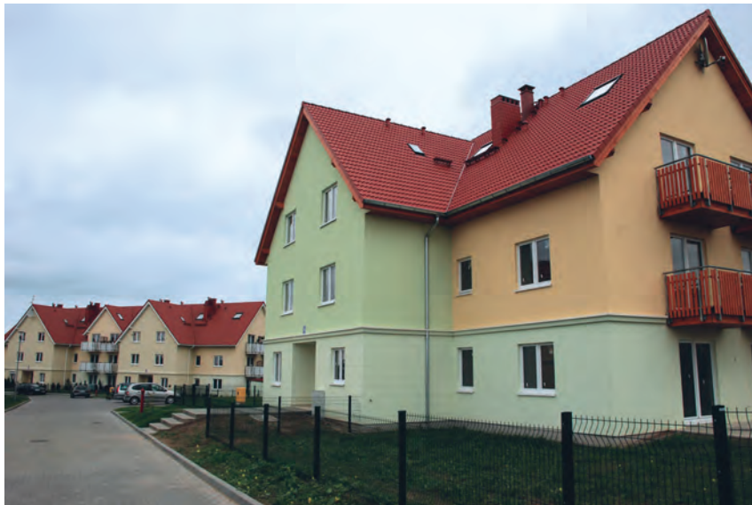
Fot. 15. Osiedle gotowe do zamieszkania (fot. Andrzej Noskowiak)
