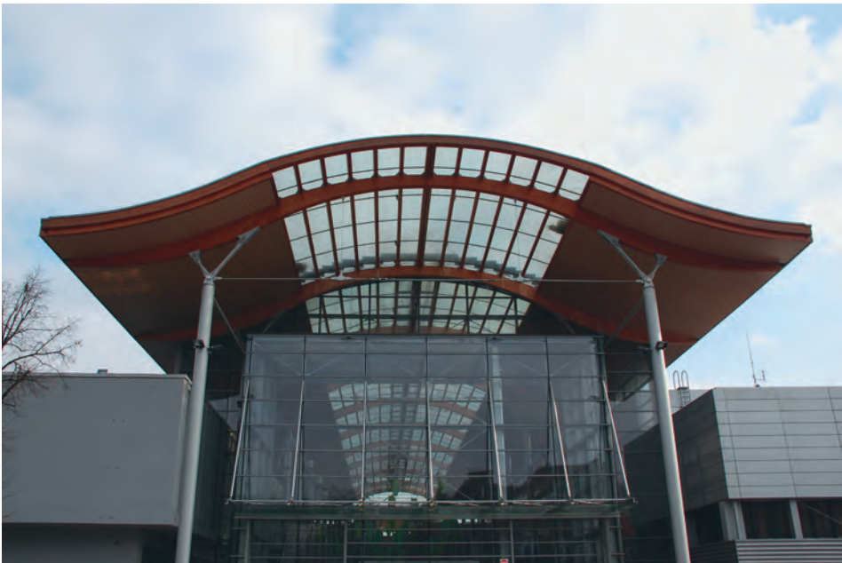
Fot. 18. Imponujący dach z drewna klejonego warstwowo na terenach Międzynarodowych Targów Poznańskich (fot. Andrzej Noskowiak)
