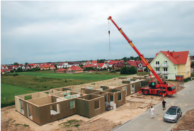
Fot. 14. Budowa osiedla w pobliżu Kołobrzegu z prefabrykowanych ścian szkieletowych (fot. Andrzej Noskowiak)
