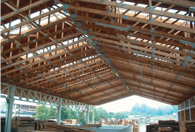
Fot. 1. Przestronna hala produkcyjna wykonana z wiązarów łączonych na płytki kolczaste w tartaku jednego z krajowych liderów innowacyjności w przemyśle drzewnym (fot. Andrzej Noskowiak)
