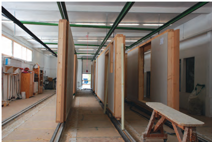
Fot. 3. Gotowe ściany, stropy i dachy domów drewnianych, powstające w fabrykach, coraz częściej wykorzystywane są na placach budowy (fot. Andrzej Noskowiak)
