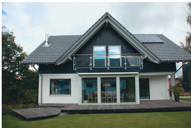
Fot. 8. Naturalnie poszarzały taras z drewna świerkowego idealnie współgra z szarym dachem i szarą elewacją poddasza nowoczesnego domu jednorodzinnego (fot. Andrzej Noskowiak)
