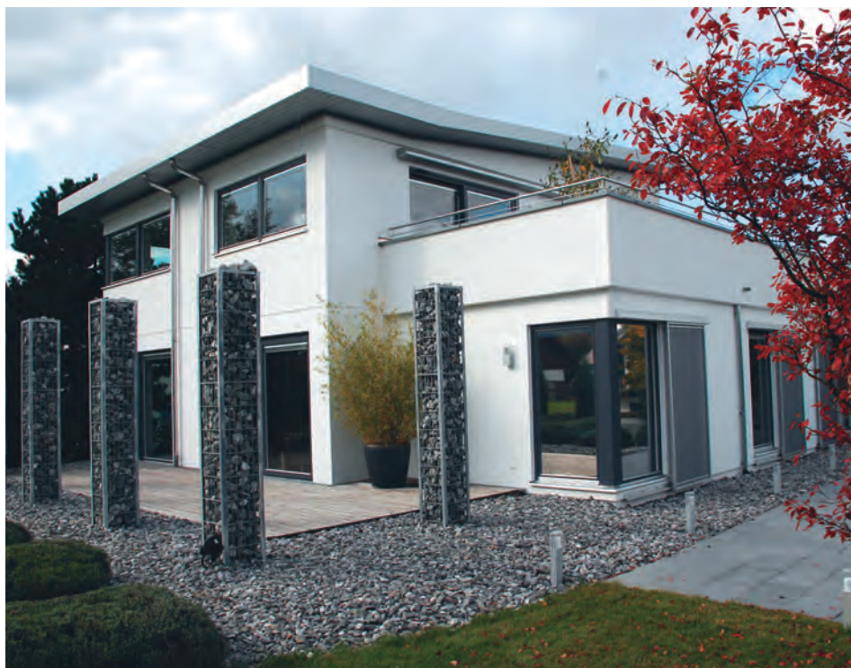
Fot. 12. Współczesny dom jednorodzinny o konstrukcji szkieletowej, prefabrykowanej (fot. Andrzej Noskowiak)
